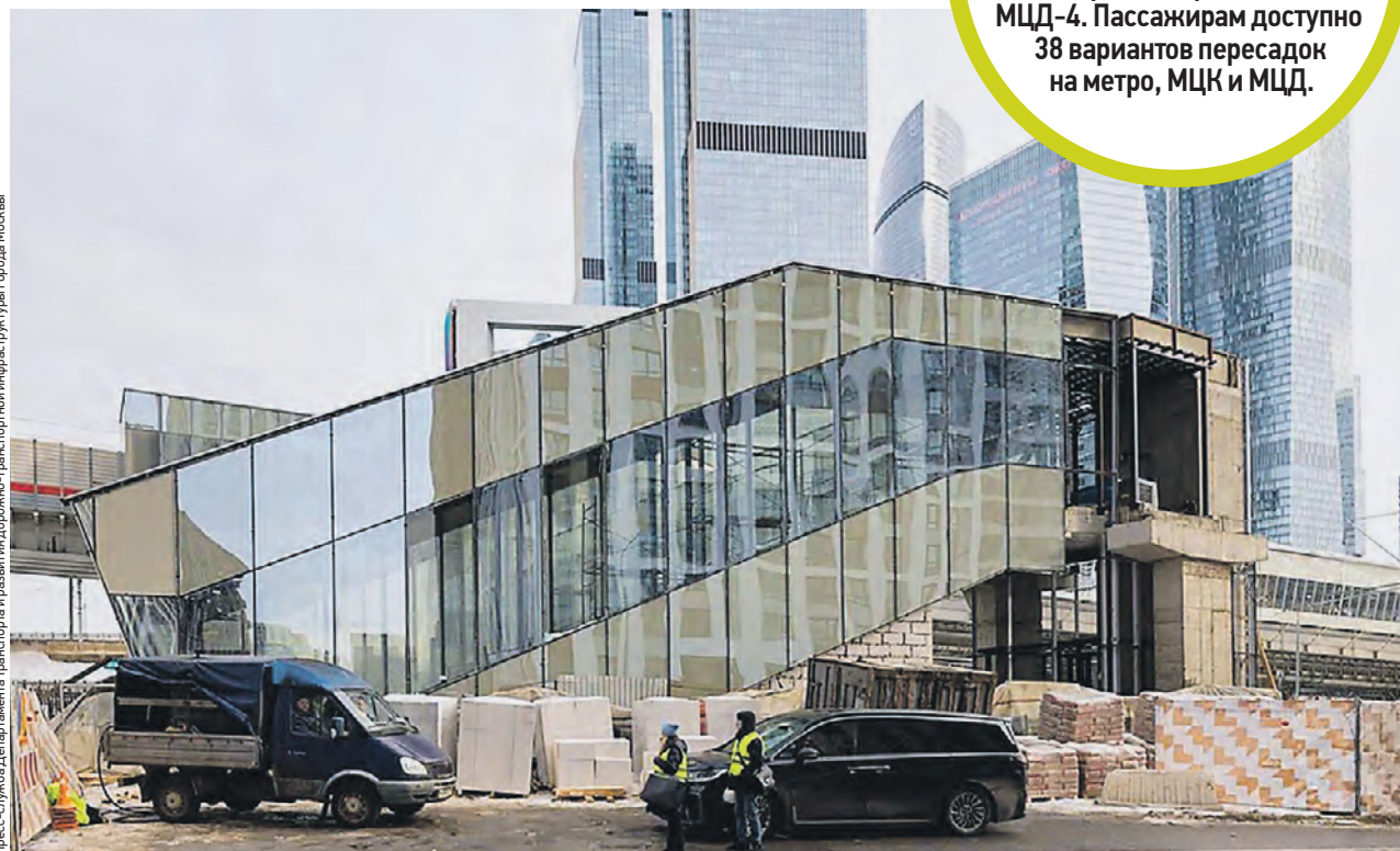
На Тестовской строят северный вестибюль и создают удобный переход к станции Деловой центр МЦК
